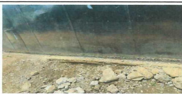
Foto 6: Mantenimiento a Portones de Metal
