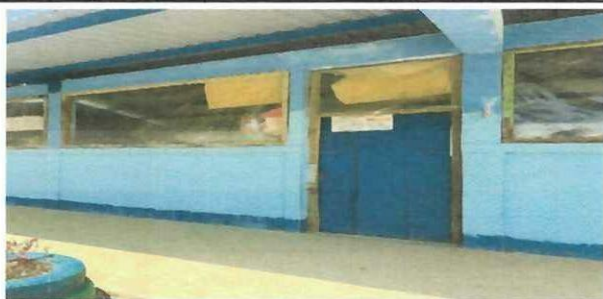
Foto 3: Sustrucción de puertas de madera
